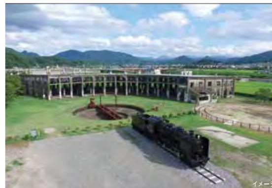
昭和4年に開業した豊後森駅に隣接している「豊後森機関庫」は、当時久大本線を走行していた蒸気機関車の石炭や水などを補給する基地として重要な拠点でした。最盛期の昭和23年頃には、25両の蒸気機関車と200人を超える職員が配置されていました。その後、蒸気機関車が姿を消すとその役目を終え、現在ではこの現存する九州唯一の「扇形機関庫」の他、車両の向きを変える「転車台」、そして大正8年に製造された「蒸気機関車」が展示されており、かつての面影を懐かしくご見学いただくことができます。
